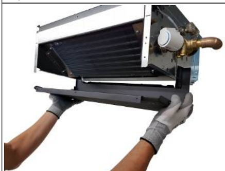
Afb. 70: Hoofdcondensaatbak (plafond) verwijderen
