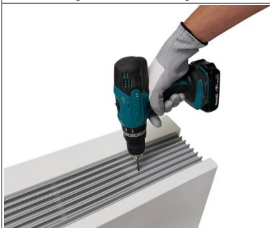
Afb. 10: Schroef het luchtuitstroomrooster vast.
