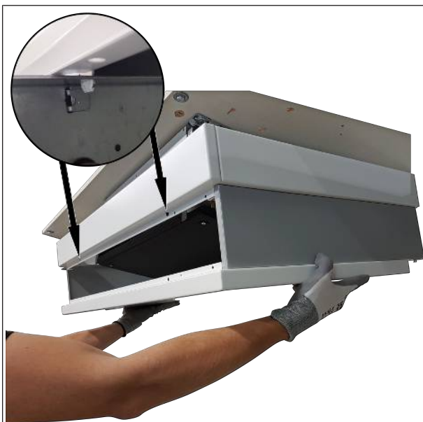
Afb. 8: Bekleding omhoog klappen en aandrukken
