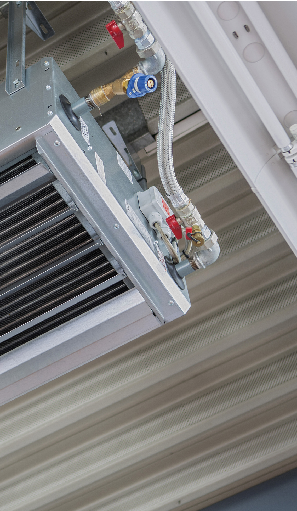
Aan het plafond gemonteerde TIP luchtverwarmers verwarmen de expositiehal van het autodealerbedrijf Seyfarth in Gotha, Duitsland.
