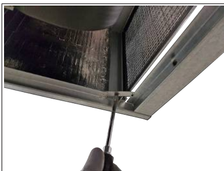
Afb. 54: Filtergrendel draaien
