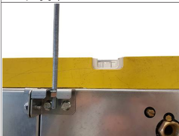
Afb. 7: Uitlijning controleren
