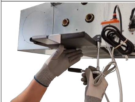
Afb. 61: Condensaatbak losmaken en vasthouden
