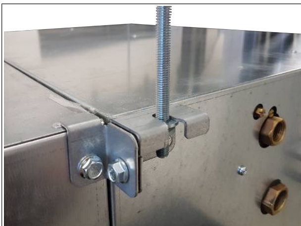
Afb. 5: Apparaat ophangen
