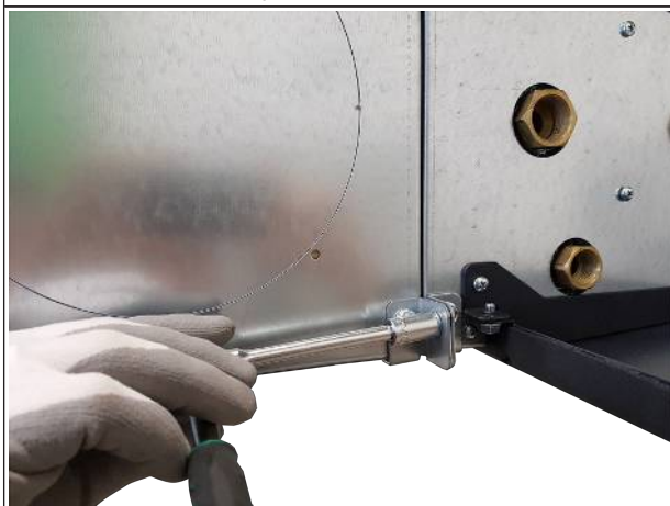
Afb. 11: Schroeven aan de buitenkant vastdraaien
