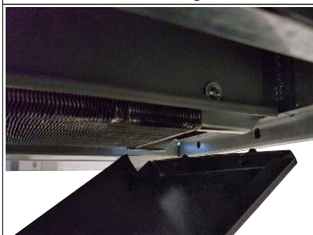
Afb. 64: Condensaatbak monteren
